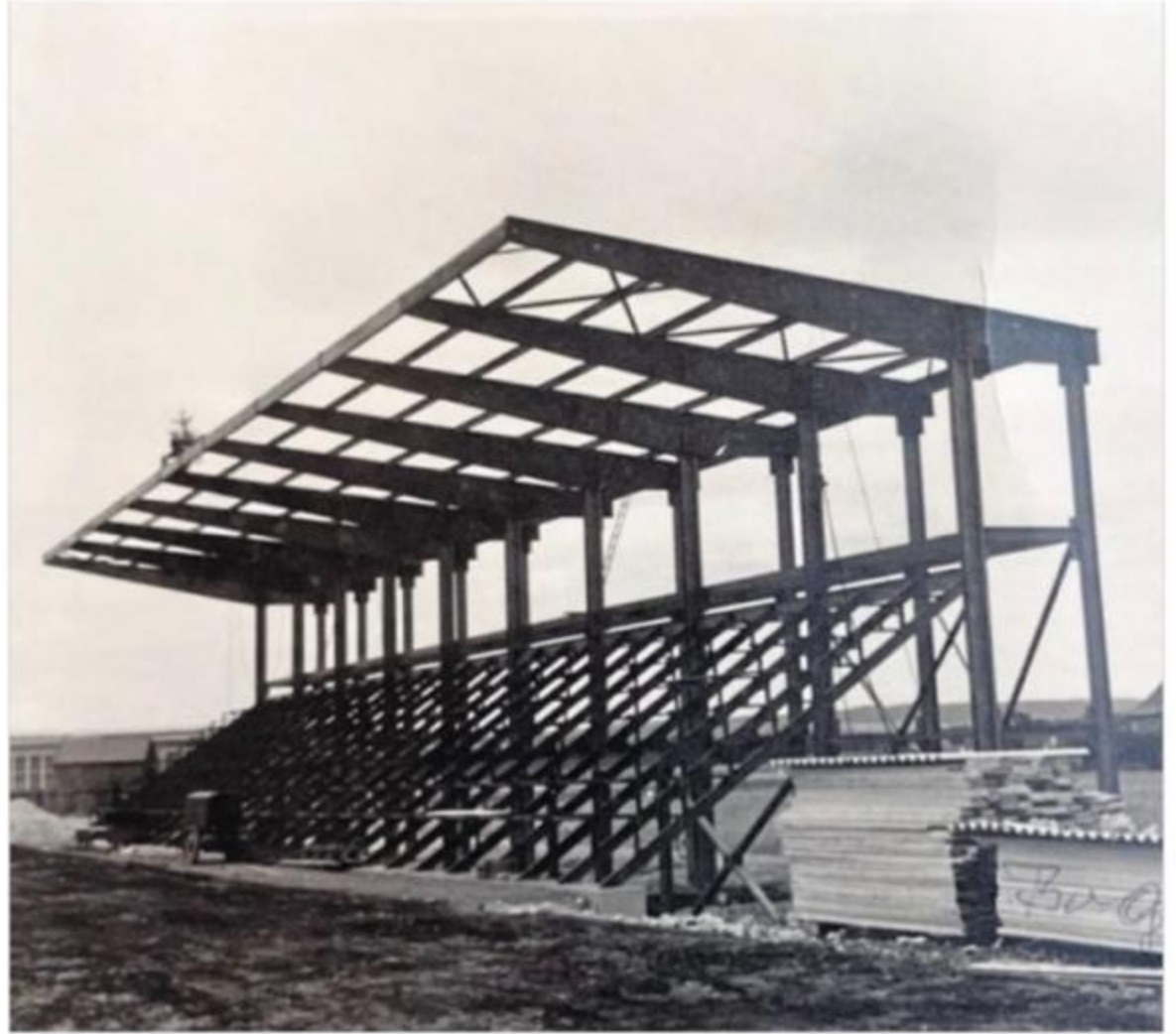
So sah die Tribüne damals im Rohbau aus, errichtet von der Firma Kölsch-Fölzer.
